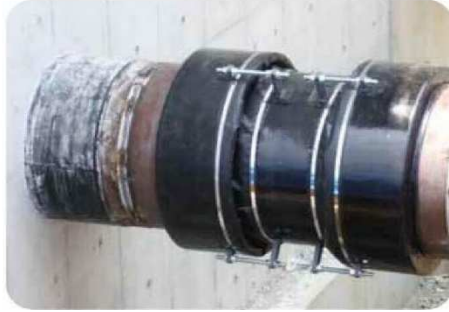
Φ800 構造物縁切り部 不等沈下吸収目的として使用
