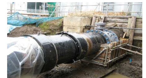
Φ900 管路耐震化工事に使用
