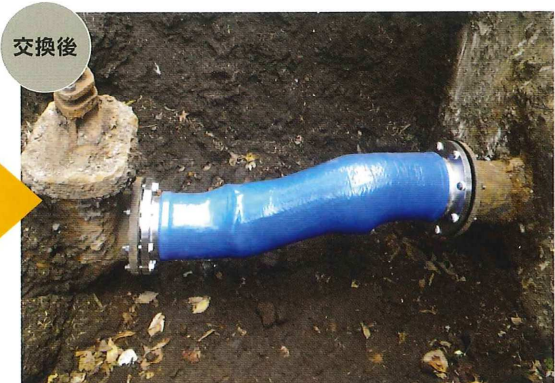
実際の配管形状に合わせた製品 さらなる沈下吸取も可能
