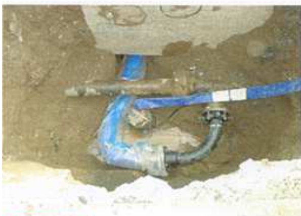
従来管では不可能なカルバートの下越しと、下越し直後の障害物迂回もシナプスフレキなら可能
