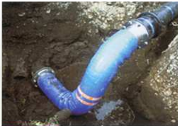
管軸が直交する高低差のある芯合わせに使用
