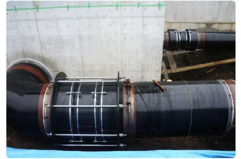
手前Φ1500 奥Φ800 配管仕様に合わせ タイロッド付と無を2台使用
