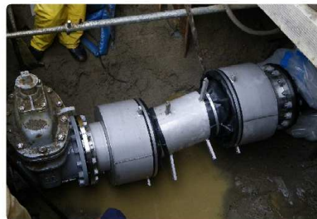
Φ300 変位済可とう管設置 更なる沈下吸収可能
