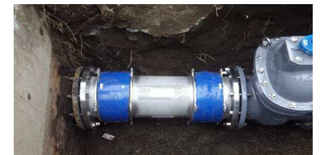
Φ350 既設可とう管取替工事
