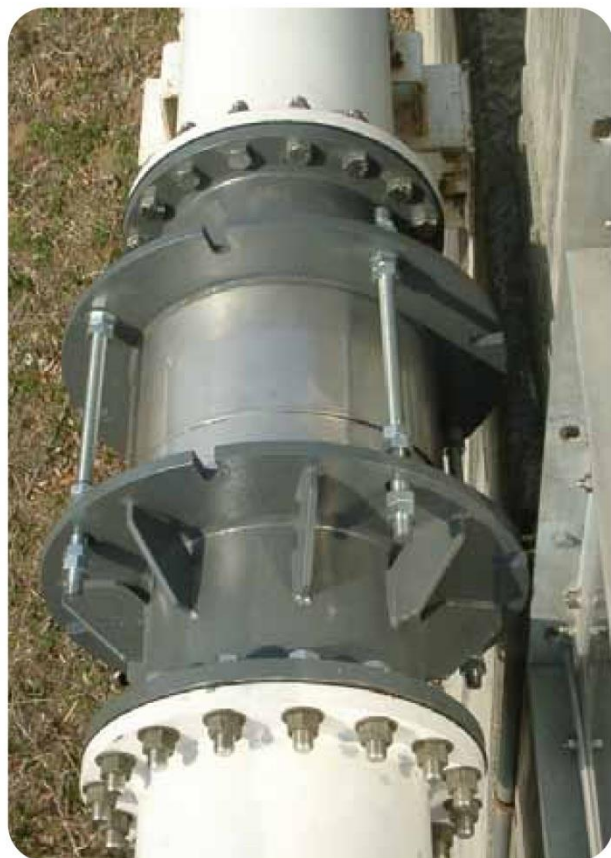
橋梁添架部での伸縮管として使用
