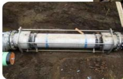
ベローズ長や中間パイプの 調整により、面間や沈下量を 自由に設計可能
