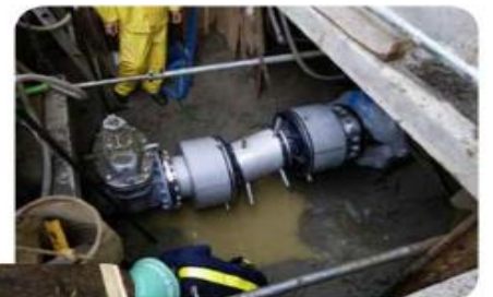
既存変位に合わせて 可とう管を施工した例
