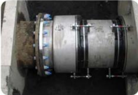
構造物取出後、可とう管として使用
