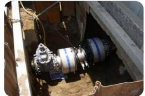
既存変位に合わせて可とう管を施工した例
