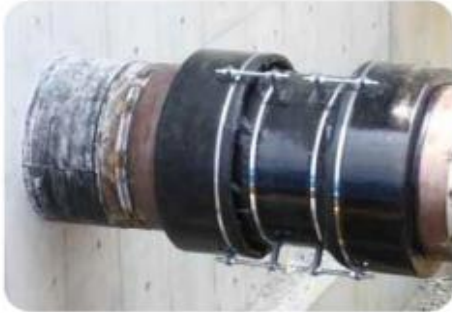
構造物取出後、可とう管として使用
