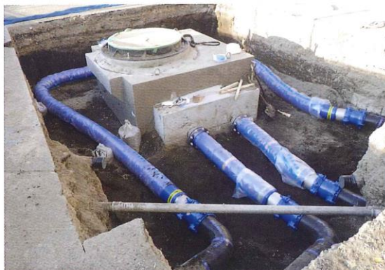
緊急遮断弁と既設管の芯合わせに曲管 および可とう管として使用
