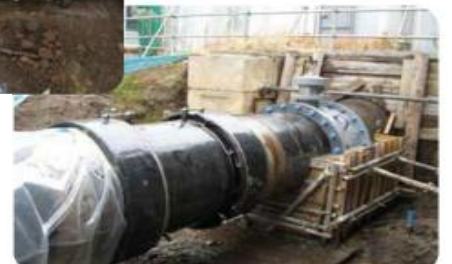
構造物取出後、可とう管として使用
