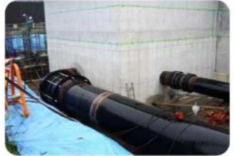
構造物取出後、曲げ配管にて タイロッド付可とう管として使用
