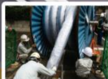
ドラム設置後引き込み開始
