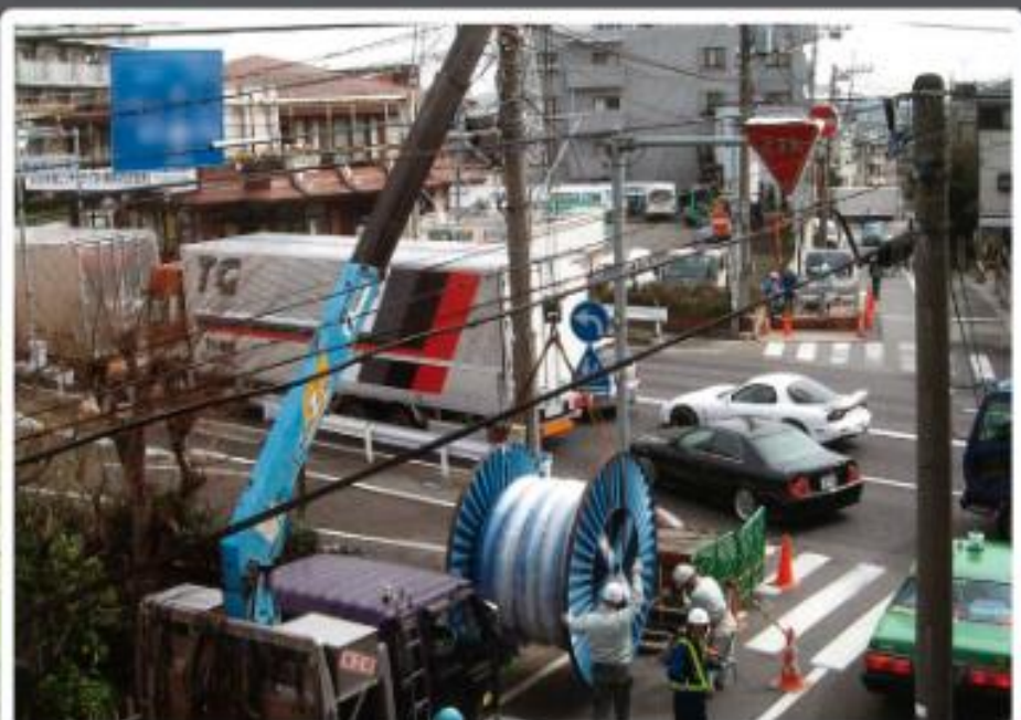
交通量が多い国道横断工事に使用。引き込み工事は約30分で終了。
